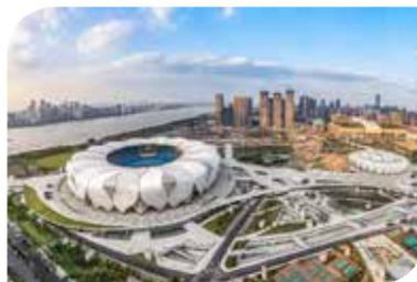
色建筑”三星级标准，以确保实现高效节能。在2015年，开利就已经为该场馆提供了高能效的30XW水源热泵机组，高稳定性的39G组合式空气处理机组以及数百台42CE风机盘管，加上开利高匹配性的群控系统，展现了超强的节能运行控制能力。在此次招标中，开利再一次被选为奥体三馆的设备供应商。
